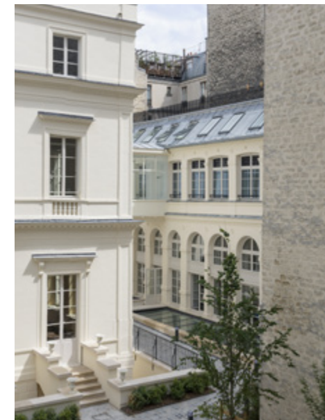
PHOTOS APRÈS TRAVAUX
